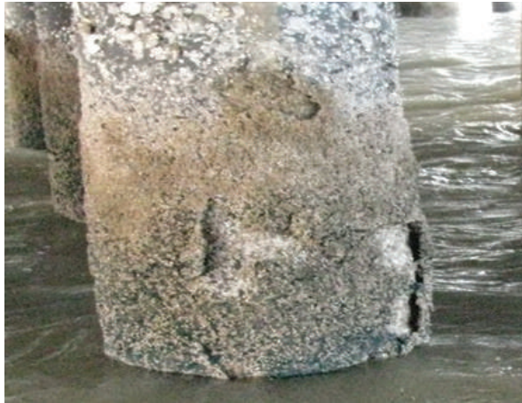
Gambar 3.10. Lapisan Coating HDPE yang Rusak Akibat Biota Laut
