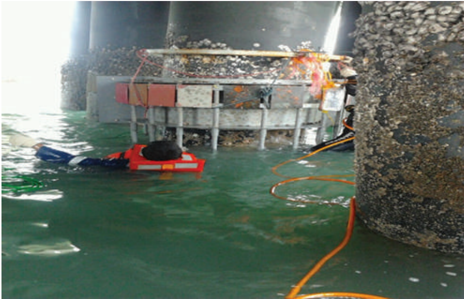
Gambar 5.3. Pemasangan Contoh Uji pada Tiang Pancang Jembatan Tol Suramadu Jawa Timur
