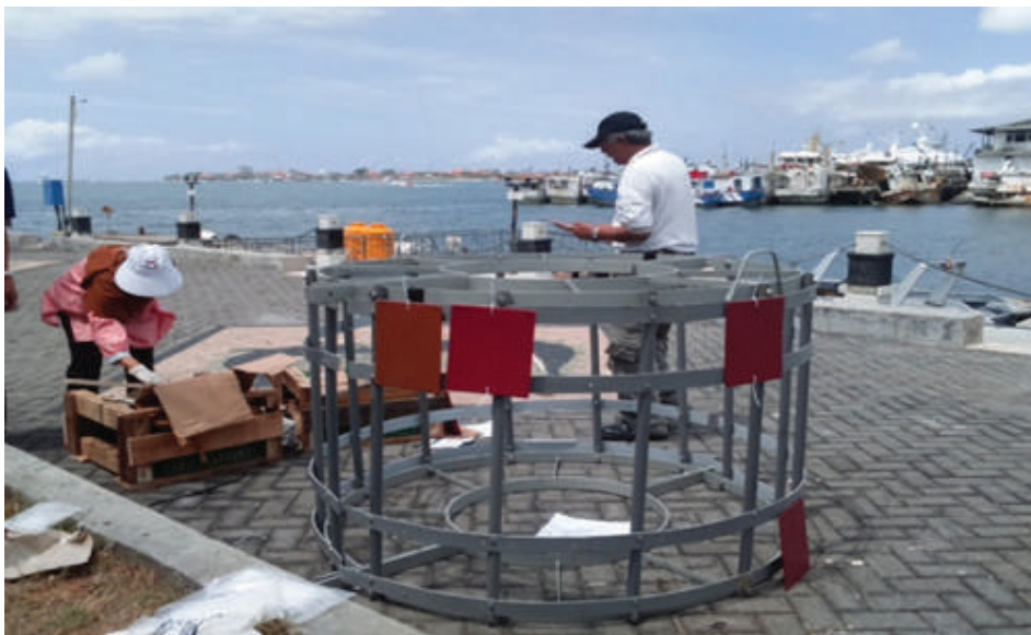
Gambar 5.4. Pemasangan Contoh Uji pada Tiang Pancang Jembatan Tol Bali Mandara
