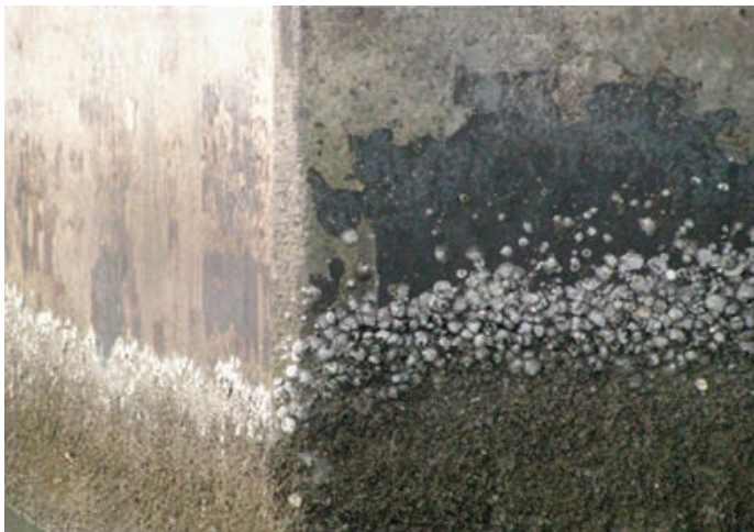
Gambar 3.9. Perbedaan Visual Kondisi Beton yang Ditemplei Teritip Dengan yang Tidak Ditemplei Teritip
