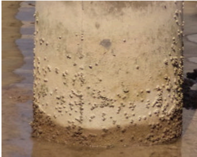
Gambar 3.7. Pengamatan Pertama Kepadatan Teritip yang Menempel Pada Tiang Pancang
