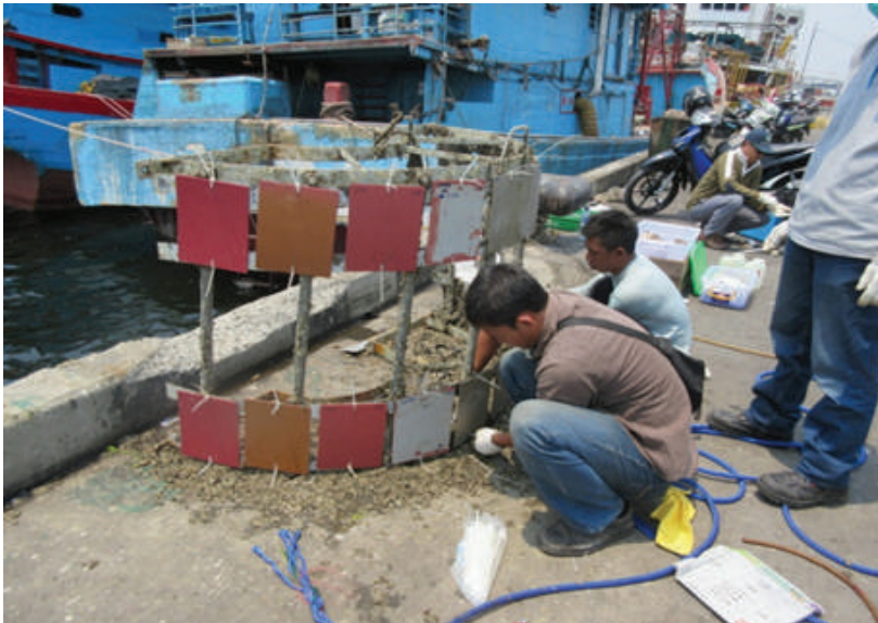
Gambar 5.2. Pemasangan Contoh Uji di Dermaga Muara Baru Jakarta
